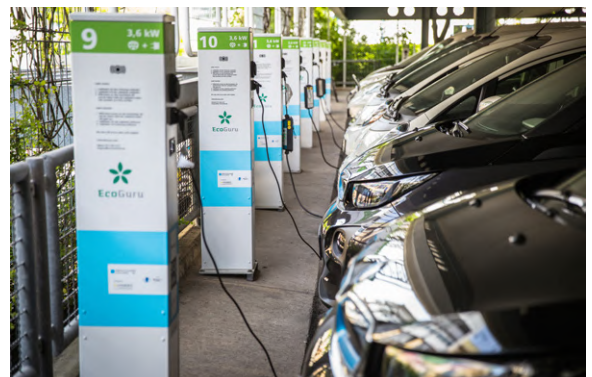
Abbildung 59: Leitwarte und Ladeinfrastruktur des Micro Smart Grid am Fraunhofer IAO.
