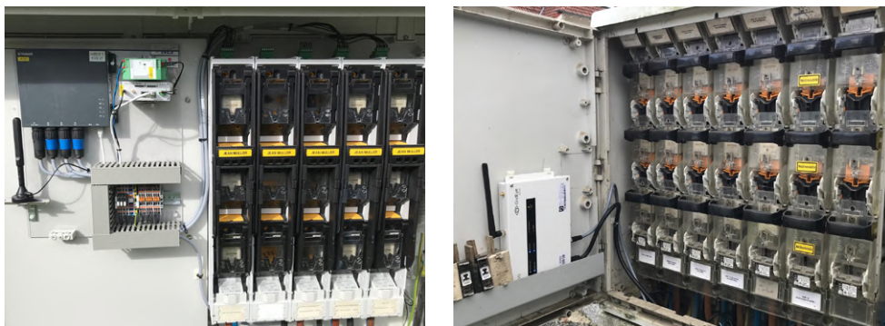
Abbildung 66: Links Teil des iNES-Messsys- tems, rechts eine GridEye-Zelle
