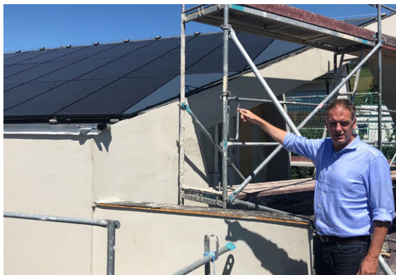
Abbildung 49: Smart Living Weinstadt im Bau, hier Installation der integrierten PV-Anlage
