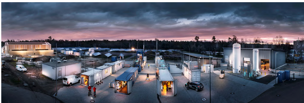
Abbildung 60: Panorama über das Energy Lab 2.0 mit Elementen des Speicherverbundes Karlsruhe/Stuttgart.
