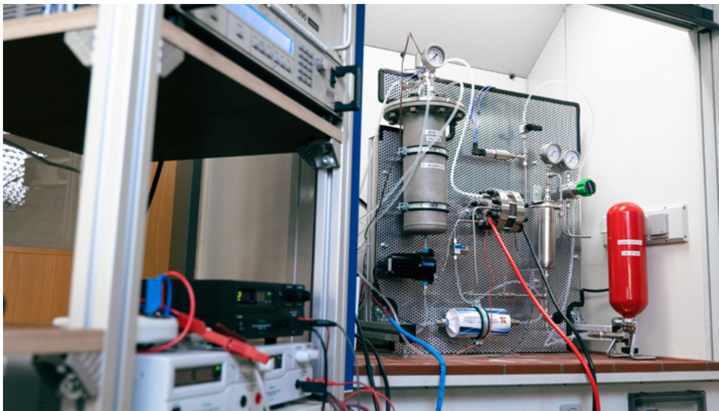
Kernstück bei der Projektentwicklung im Labor ist der Elektrolyseur, in dem der Wasserstoff mittels Strom hergestellt wird. Für dessen Betrieb wurde die komplette Systemtechnik installiert, die auch für größere Tankgeräte benötigt wird.
