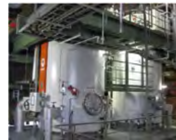
Elektrodampferzeuger 2 x 20 MW
